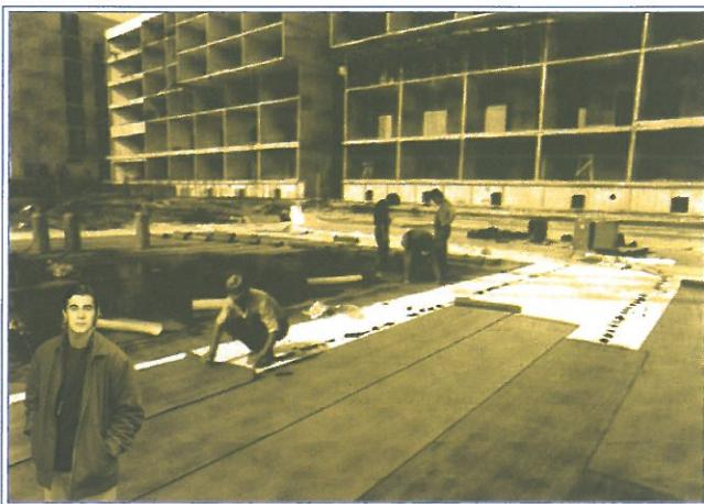
Priprema i štosovanje traka pri izvođenju hidroizolacije
