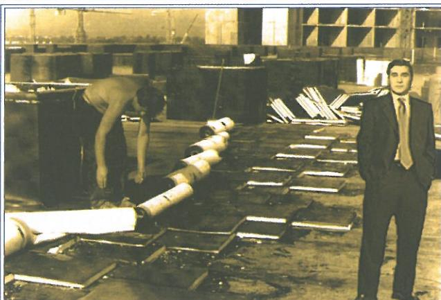
Postavljanje, termo i hidroizolacije, na ravnom krovu
