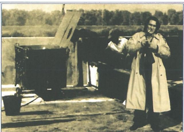
Izvođenje hidroizolacije trakama lepljenim vrućim bitumenom
