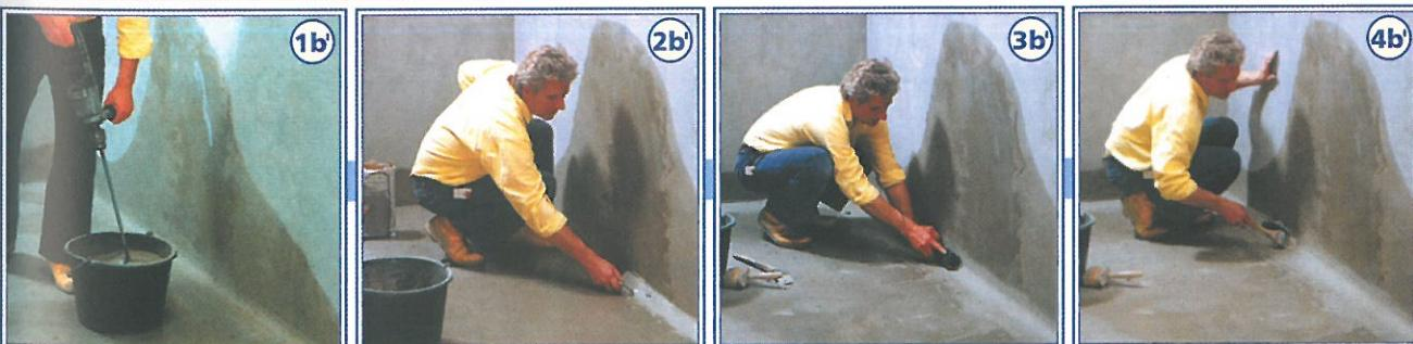
**Detalj B: IZVOĐENJE "SLEPOG HOLKELA":** slika B) 1b' - PRIPREMA **TP MALTERA**, 2b' - NANOŠENJE **TP-MALTERA**, mistrijom u uglu na spoju pod-zid. 3b' - OBRADA **TP-MALTERA** okruglom gletericom (ili pivskom flašom) da se dobije zaobljena hipotenuza. 4b' - RAVNANJE ZAOBLJENE HIPOTENUZE "SLEPOG HOLKELA" četkom pre nanošenja trećeg premaza sa (**TP-4MS**).
