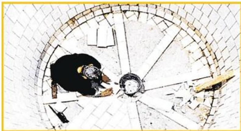
Jedna nova generacija materijala za izradu elektroprovodnih premaza i obloga zauzela je svoje istaknuto mesto. Elektroprovodljivost se postiže umešavanjem elektroprovodljivih punioca (provodljivi Asplit crni prah).
