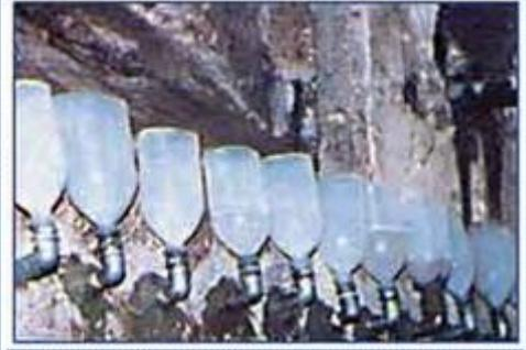
**Slika 10:** Pojedini izvođači, da ne bi (TP-LP-4MS (Tip A)) nalivali u rupe (4-5 dana minimum), u sve rupe ugrade moždanike sa plastičnim flašama koje postave i napune ih utroškom po iskustvu tečnim (TP-LP-4MS (Tip A)) - tabela 4 g h, i ostave da se zid zasićuje i оформљава horizontalnu hidroizolaciju.
