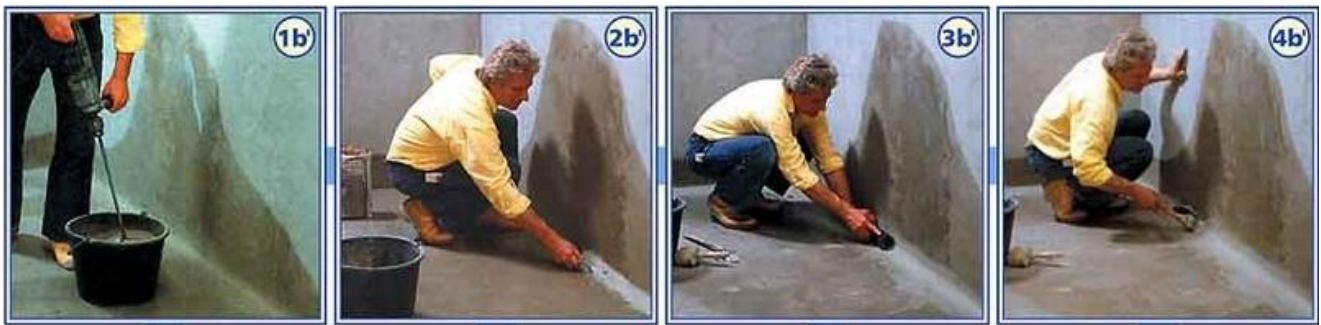
**DETALJ B: IZVOĐENJE SLEPOG HOLKELA:** SLIKA B): **1b** - priprema **TP MALTERA**, **2b** - **NANOŠENJE TP MALTERA** mistrijom na uglu na spoju zid - pod, **3b** - obrada **TP MALTERA** okruglom gletericom (ili pivskom flašom) da se dobije zaobljena hipotenuza, **4b** - **RAVNANJE ZAOBLJENE HIPOTENUZE "SLEPOG HOLKELA"** četkom pre nanošenja trećeg premaza sa (**TP-4MS**).
